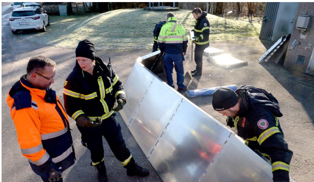
Figur 51. Räddningstjänsten sätter upp översvämningsskydd under översvämningen 2020 (Laholms kommun).
